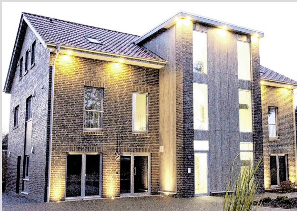
Innerhalb von rund zwölf Monaten wurde das Wohn- und Geschäftshaus an der Ostertorstraße 20 fertiggestellt. BILDER: PRIVAT
